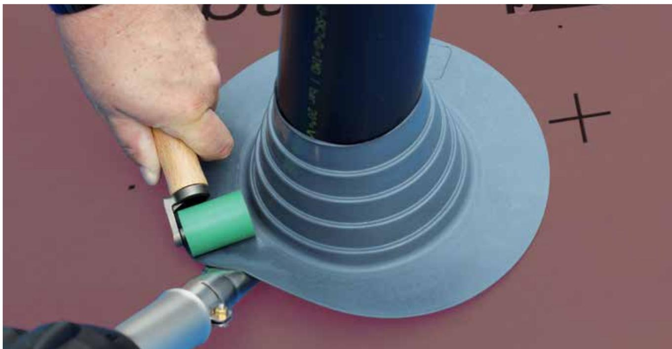
**Heizkeil-Schweissgerät für Überlappungen von difuroof extrema Bahnen**
